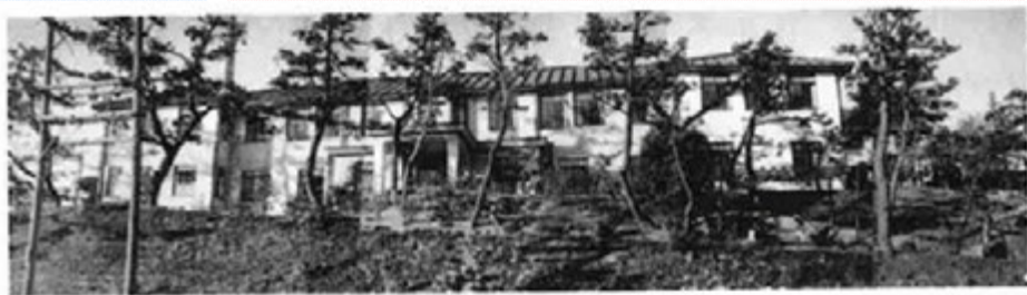
完成した30床の病院(昭和22)
